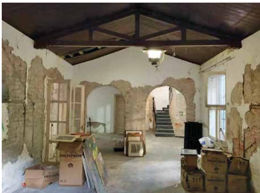
Figura 4.36. Interior del salón principal y arcos de acceso al comedor (izq.). Hall de distribución (dcha.) (Fuente: Gregory Vertullo, 2022).
