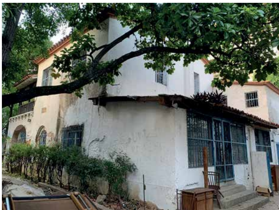
Figura 5.10. Fachadas oeste y sur de la quinta Solete que muestra el corredor agregado en la década de 1950 (Fuente: Gregory Vertullo, 2022).
