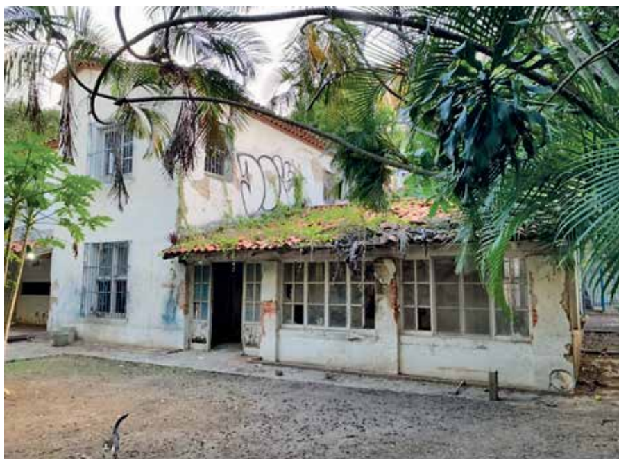
Figura 5.12. Corredor del jardín interior con los cerramientos acristalados incorporados en la década de 1950 (Fuente: Gregory Vertullo, 2022).
