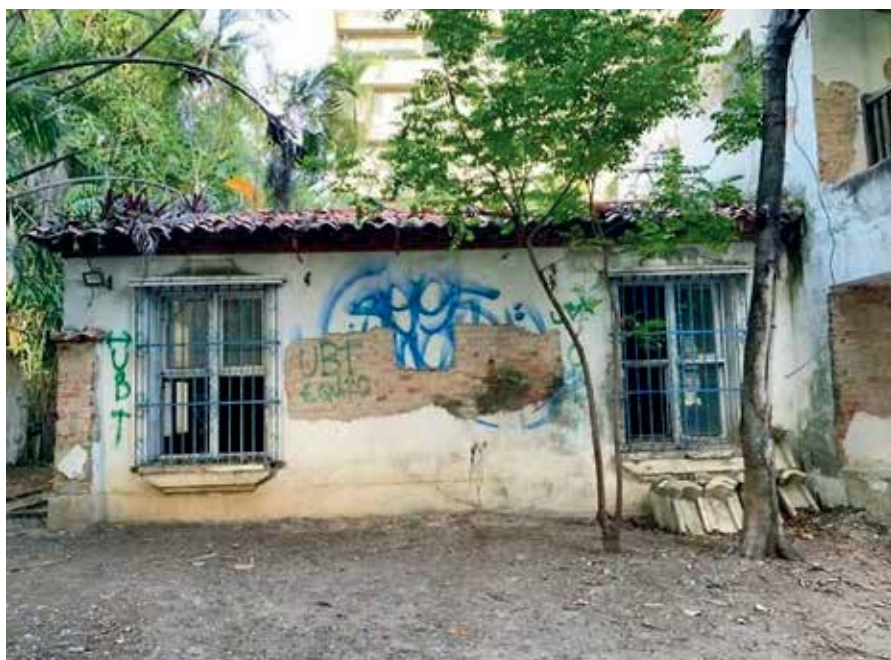
Figura 4.34. Ventanas del salón principal con rejas voladas, apoyadas sobre repisas y rematadas en quita-polvos (Fuente: Gregory Vertullo, 2022).
