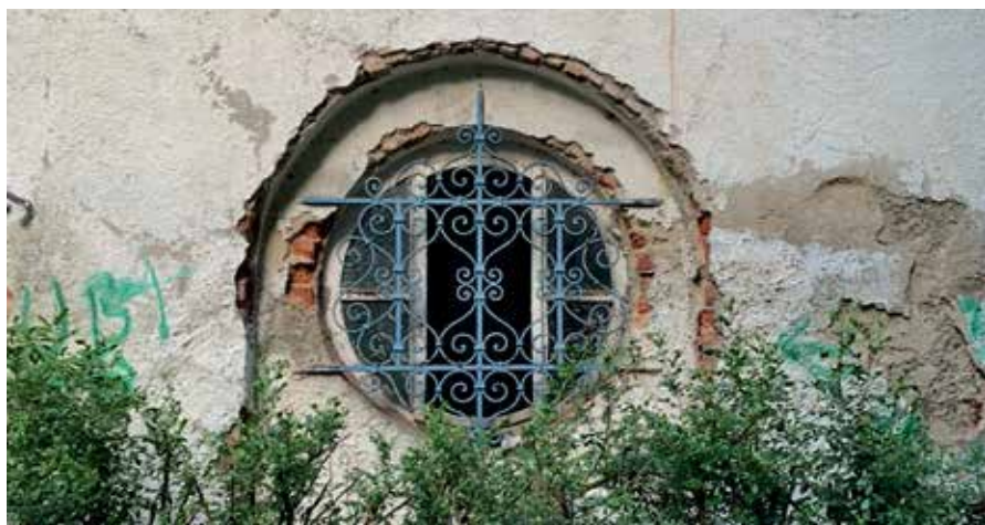
Figura 4.35. Detalle de la reja del baño de la planta baja (Fuente: Gregory Vertullo, 2022).
