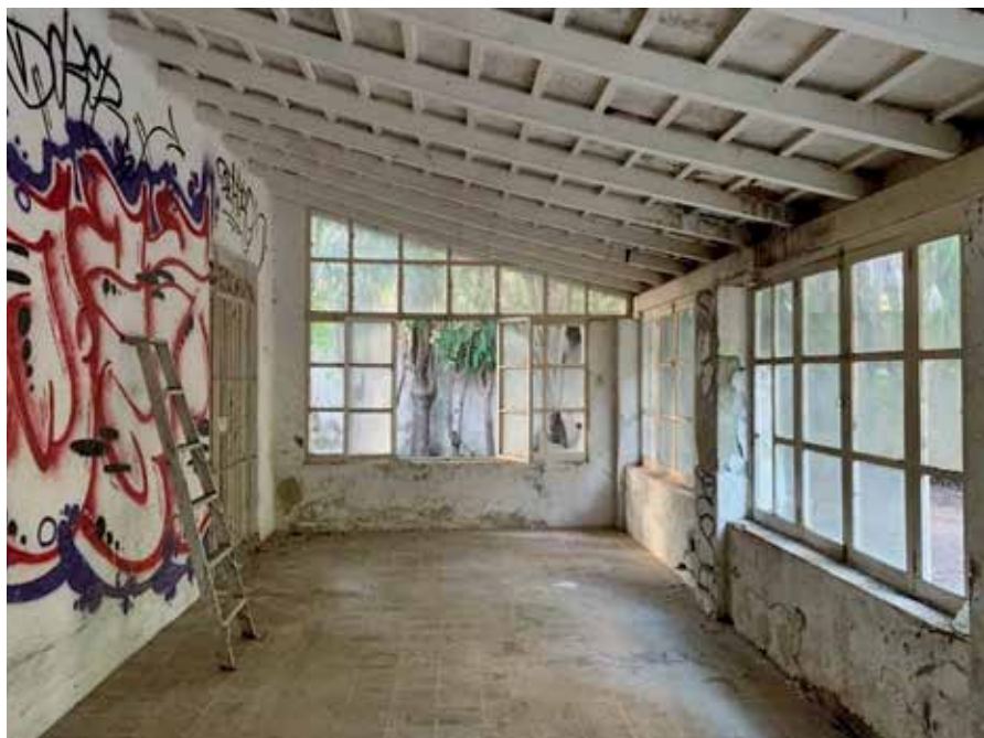
Figura 5.13. Corredor del jardín interior con los cerramientos acristalados agregados en la década de 1950 (Fuente: Gregory Vertullo, 2022).
