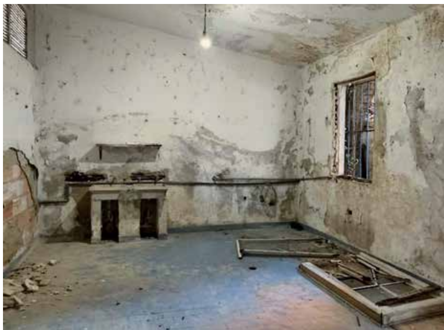
Figura 5.15. Nuevo lavadero, habilitado al fondo de la parcela (Fuente: Gregory Vertullo, 2022).
