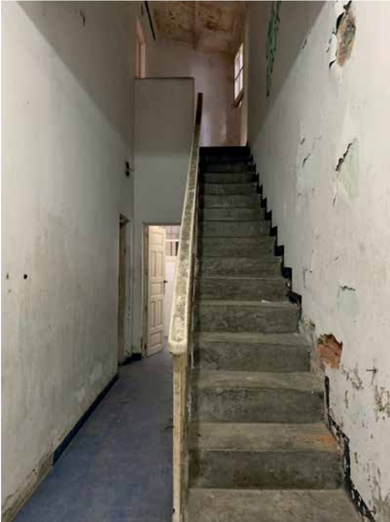
Figura 4.41. Corredor de servicio a doble altura y escalera que conduce a la terraza del lavadero de la quinta Solete (Fuente: Gregory Vertullo, 2022).
