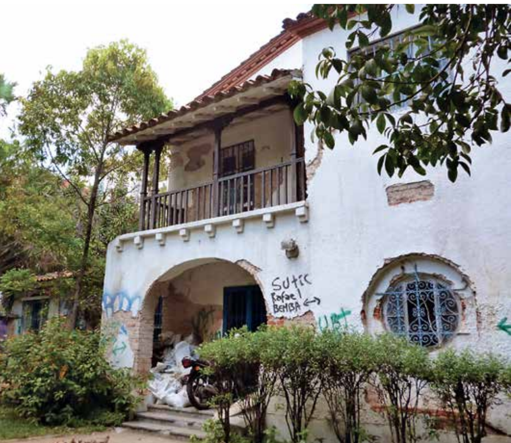
Figura 4.27. Quinta Solete: fachada oeste y porche de acceso (Fuente: Arq. Gregory Vertullo, 2022).
