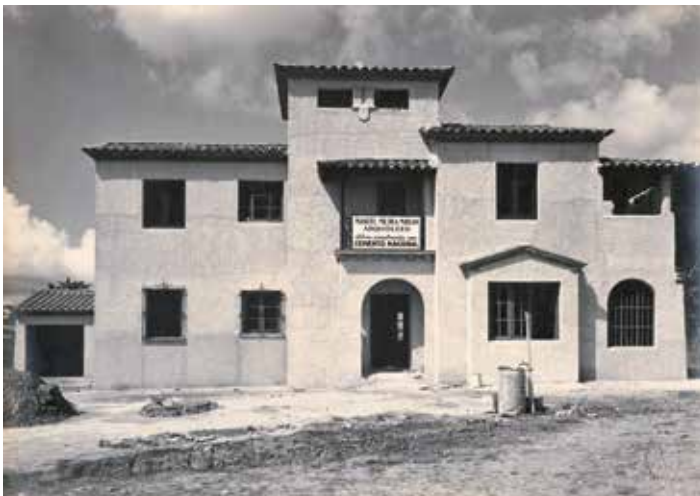
Figura 4.30. Simón Núñez García (fotógrafo, hacia 1938). La quinta Torre Montería en construcción (Fuente: González Casas y otros, 2020).
