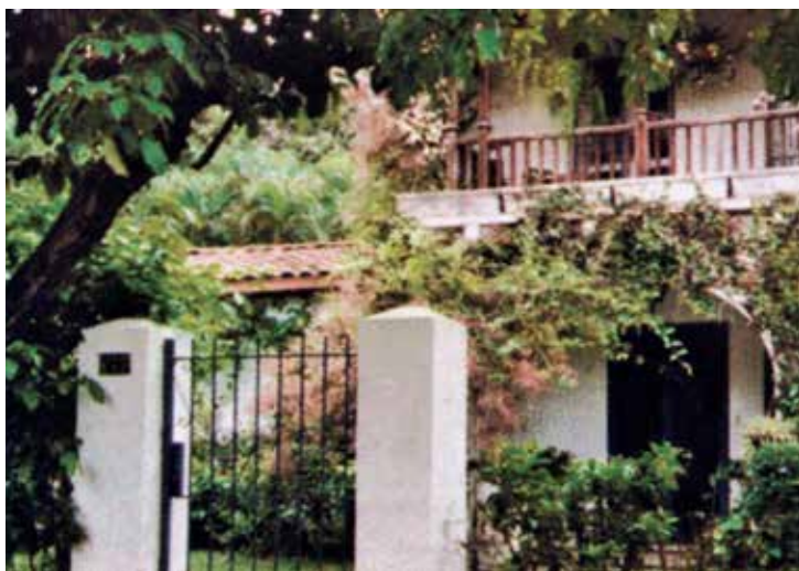
Figura 6.3. Estado de la edificación en 1983 (Fuente: FMU, 2014).
